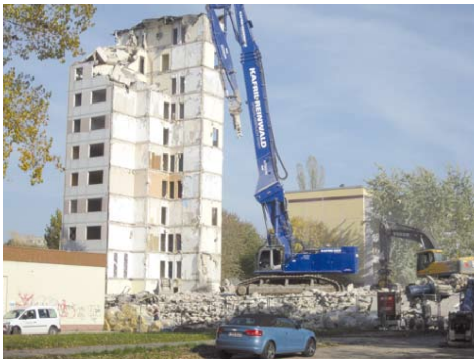
Obrázek 1 Bourání prázdných panelových domů v Halle Neustadtu 10
