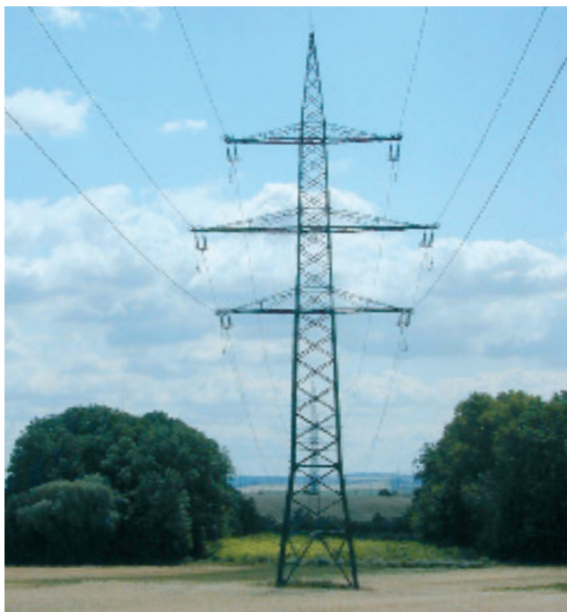
Soudek - kotevní Barrel tower - Anchor tower
