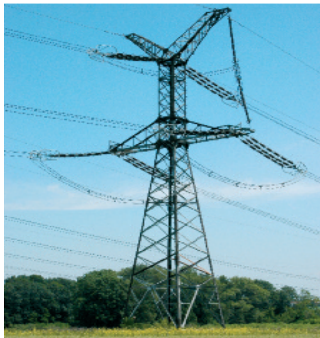
Mačka - kotevní “ Mačka ” tower - Anchor tower
