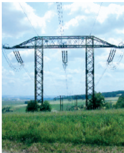
Portál - kotevní Portal tower - Anchor tower
