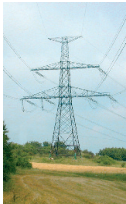
Donau - kotevní Donau tower - Anchor tower
