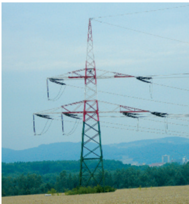
Donau - kotevní Donau tower - Anchor tower
