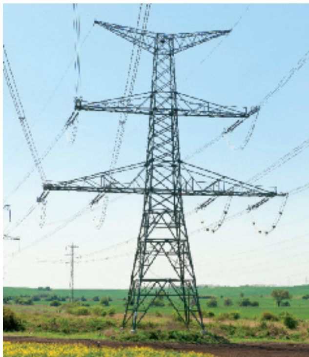
Donau - kotevní Donau tower - Anchor tower
