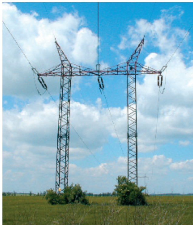
Portál - kotevní Portal tower - Anchor tower
