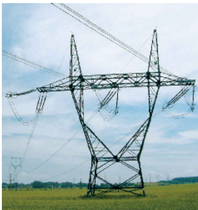
Kočka - kotevní "Cat head" tower - Anchor tower
