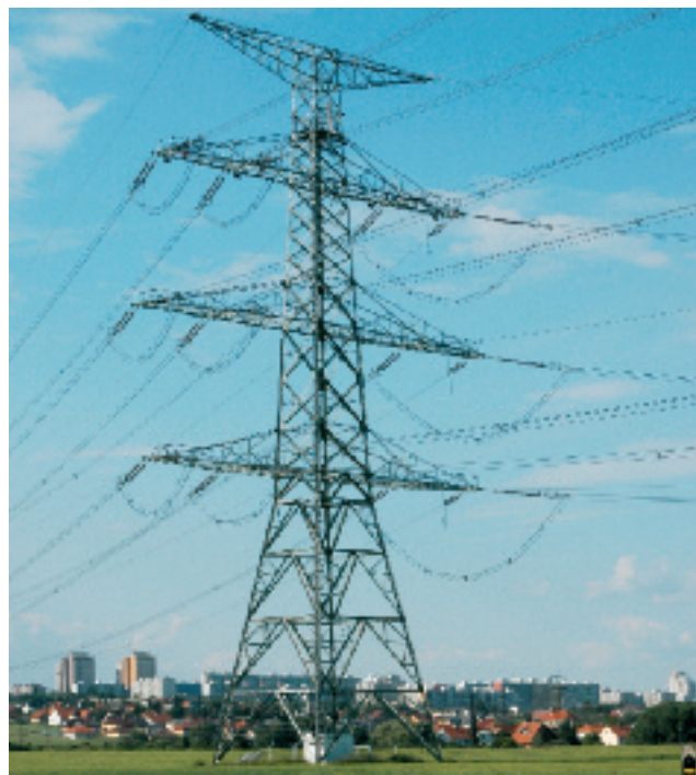
Sudek - kotevní s vedením o různé napěťové hladině (3x400+220 kV) Barrel tower - Anchor tower carrying power lines with different voltage levels (3x400+220kV)
