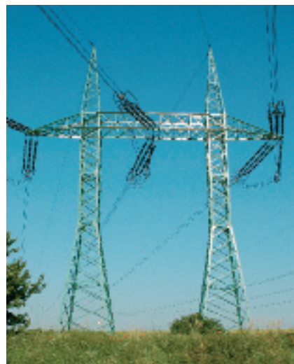
Portál - kotevní Portal tower - Anchor tower
