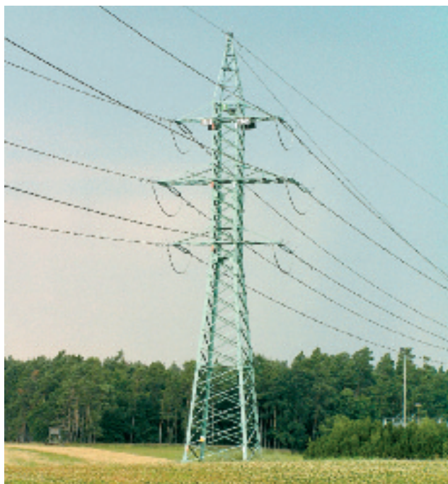
Soudek - kotevní Barrel tower - Anchor tower
