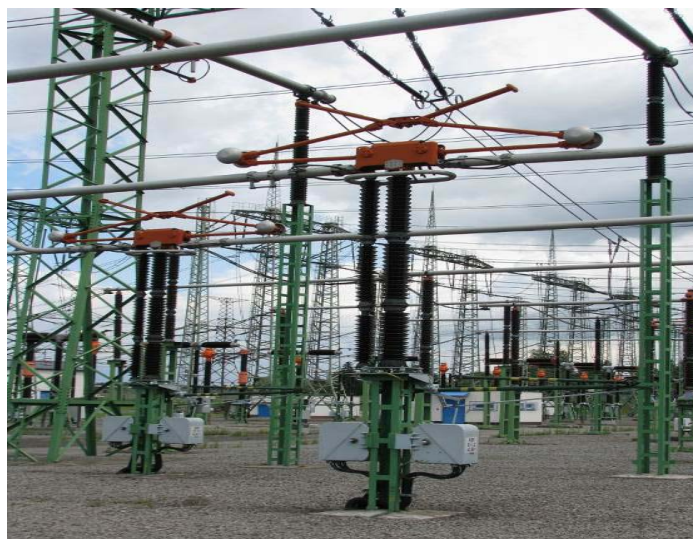
Obr. 16: Pantografový odpojovač se zemničtem
