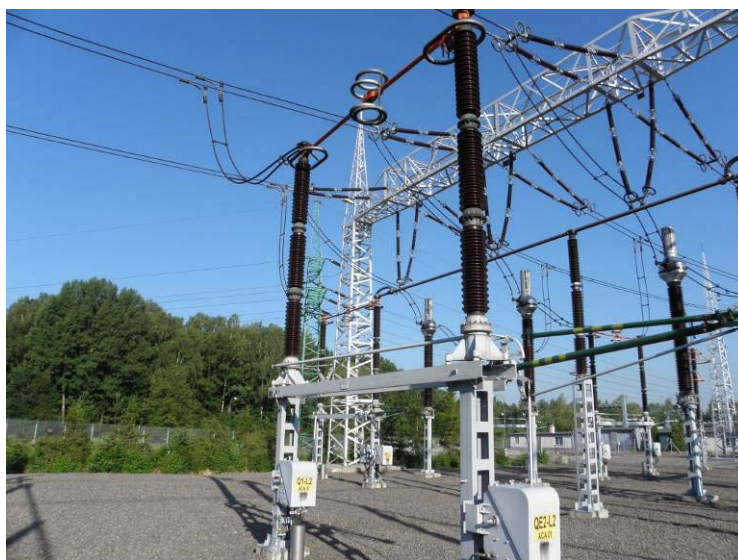
Obr. 15: Odpojovač se dvěma otočnými kontakty a zemničem
