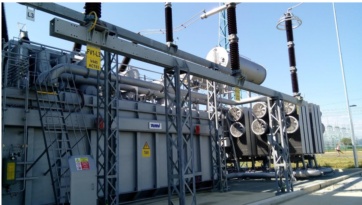
Část transformátoru s příčnou regulací
