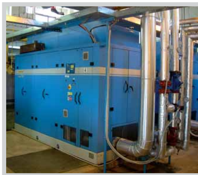
Kogenerační jednotka přeměňuje bioplyn na elektřinu a teplo. Foto: Jiří Beranovský, EkoWATT
