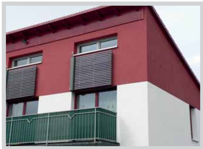
Trubicové vakuové kolektory na fasádě jako architektonický prvek. Foto: Karel Srdečný, EkoWATT
