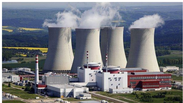
Obr. 15: Jaderná elektrárna Temelín (zdroj: byznys.ihned.cz )
