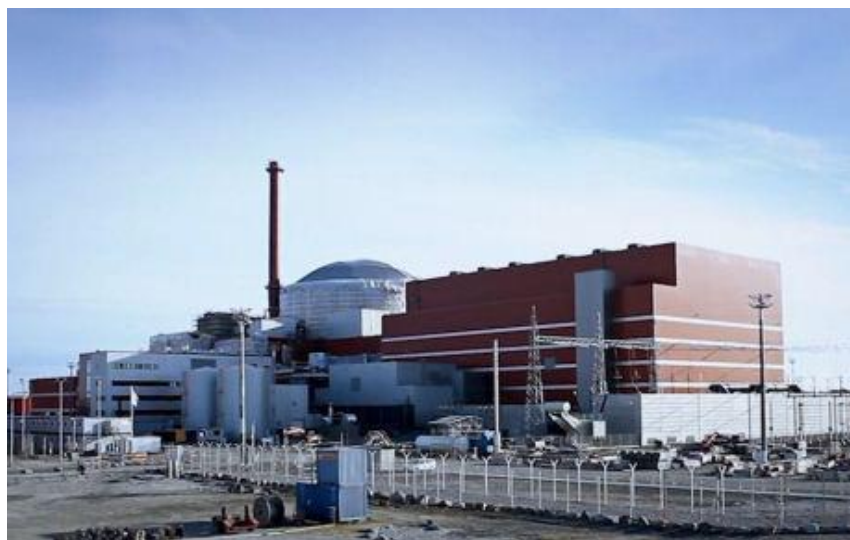
Obr. 25: Nový třetí blok jaderné elektrárny Olkiluoto ve Finsku (zdroj: www.osel.cz )
